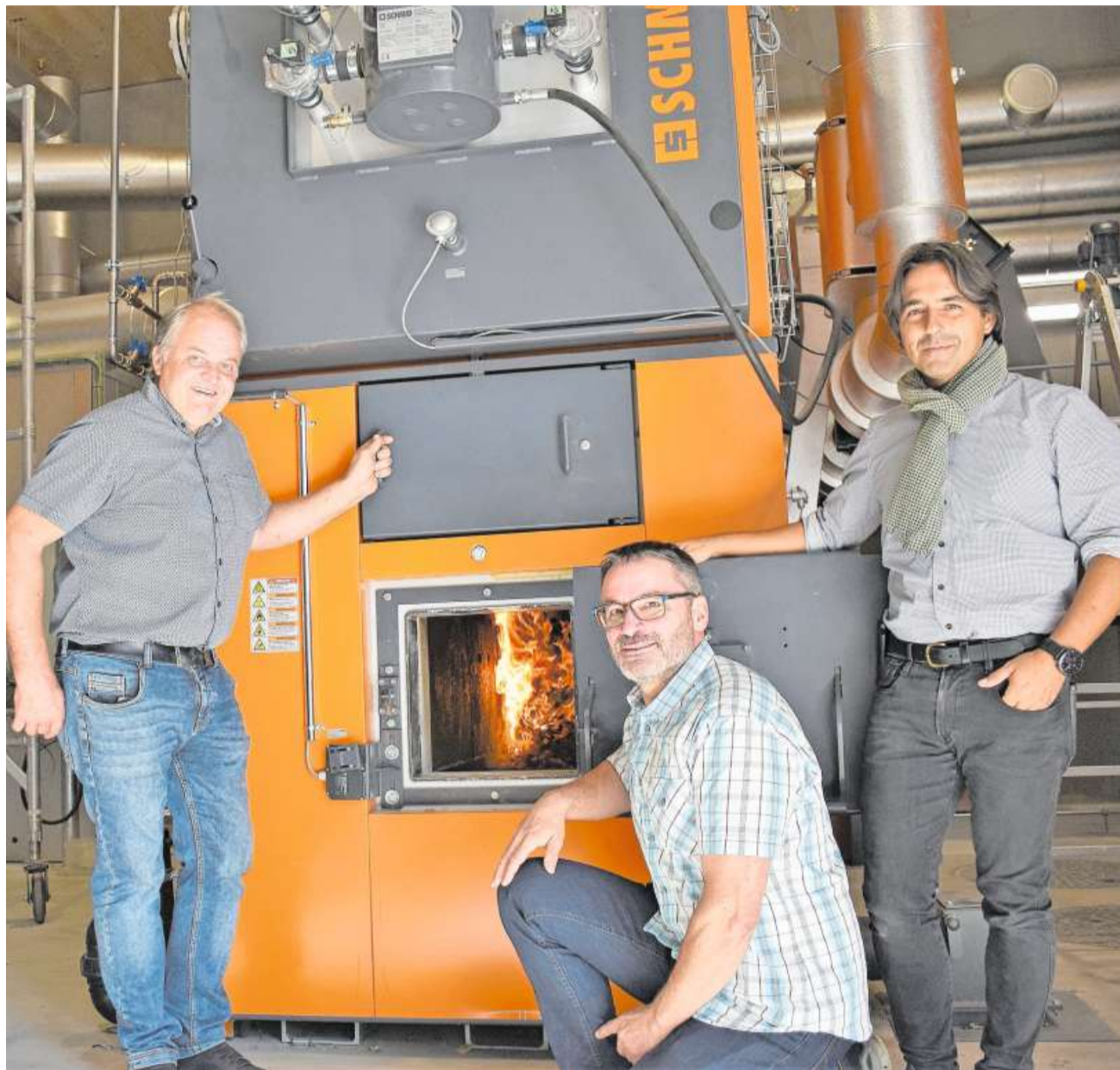
Das Feuer brennt! Gregor Blattmann, Robi Püntener und Oliver Weisbrod (von links) freuen sich über die Inbetriebnahme der Schnitzelheizung. (Bild Marianne Voss)
